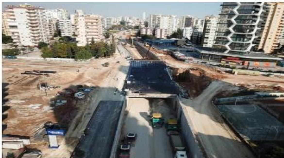
*Yenişehir ilçesinde Hüseyin Okan Merzeci Bulvarı ile 20. Cadde kesişiminde çalışmalarını başlattığı Katlı Kavşak Projesinde son aşamaya gelindi. Bordür ve kaldırımların çalışmalarına tüm hızıyla devam eden ekipler, sıcak asfalt dökümüne de başladı. Proje kapsamında toplam 20 bin ton sıcak asfalt dökülmeye planlanıyor.*
